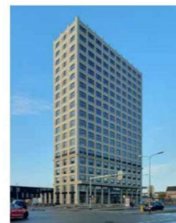
Staalframe gevellementen voor woontoren Libertas aan het Wouter van Doeverenplein in Groningen.
