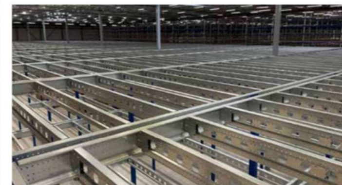
Een mezzaninevloer van twee verdiepingen met overspanningen van 12 meter en vloerlasten van 5,0 kN/m 2 tot 7,5 kN/m 2 in staalframeprofielen.
